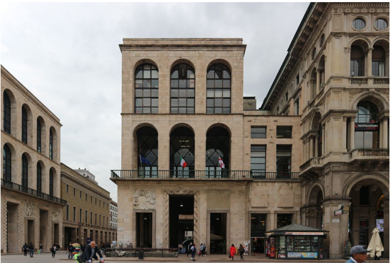
fig. 32 Vista dall'esterno della torre del Secondo Arengario.
